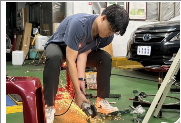
學習鑽鋼鋸切的工法
